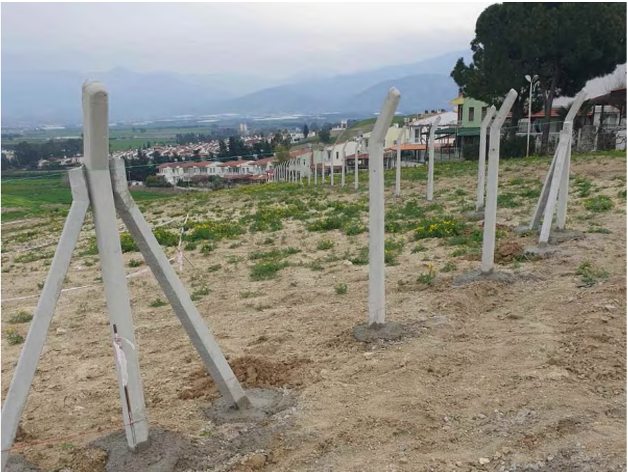
사진3. 건축 부지 펜스 설치
