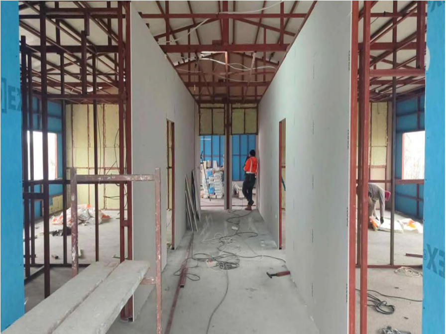
사진7. 문화센터 칸막이 공사 (2024.01.03.)
