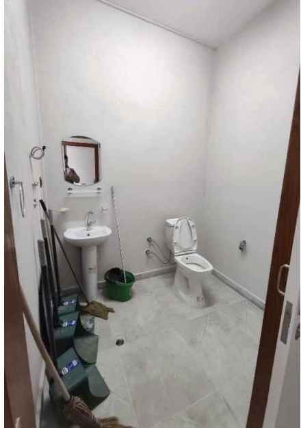
사진13. 문화센터 화장실 공사 (2024.02.05.)
