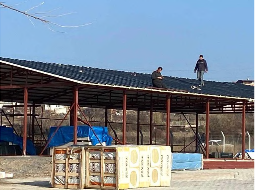
사진6. 문화센터 지붕 샌드위치 판넬공사 (2023.12.28.)
