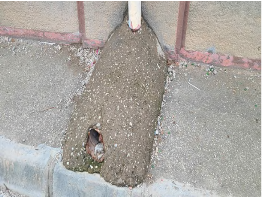
사진5. 학교 내 배수로
