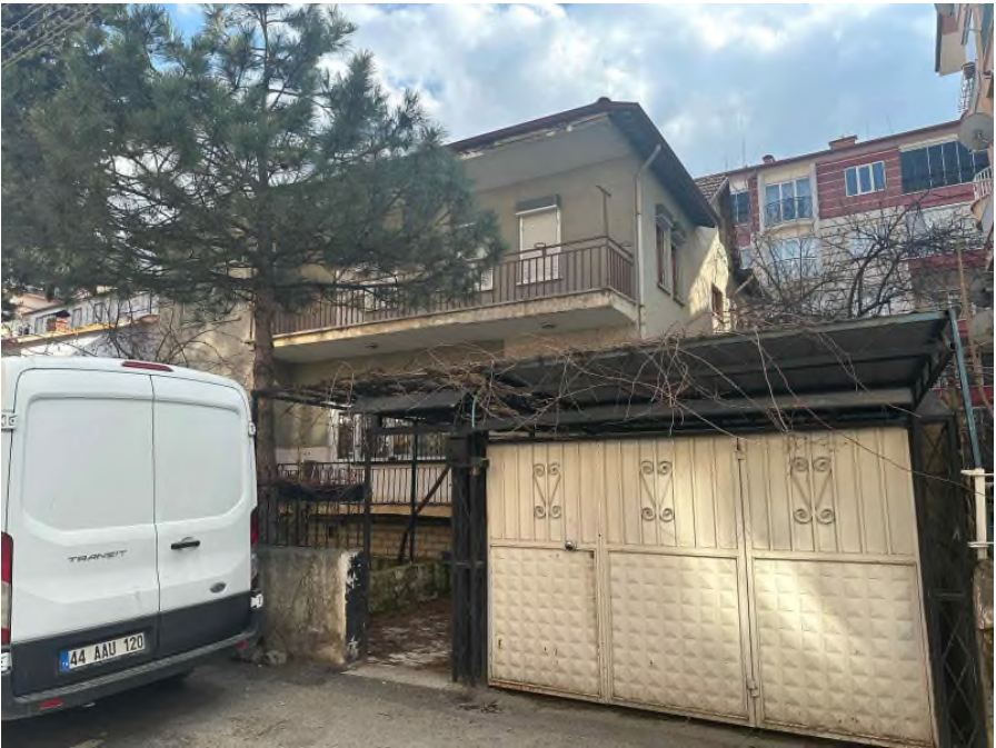
사진3. 부지 후보(폐건물, 철거 후 건축 필요)
