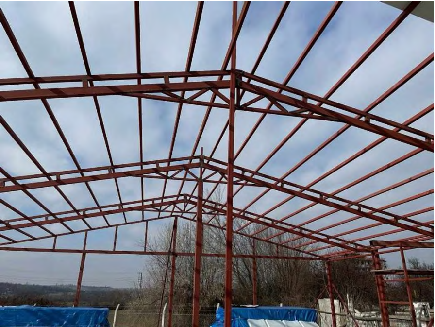
사진5. 문화센터 지붕 골조공사 (2023.12.28.)
