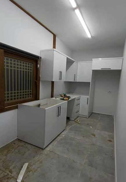
사진12. 문화센터 주방가구 공사 (2024.02.05.)
