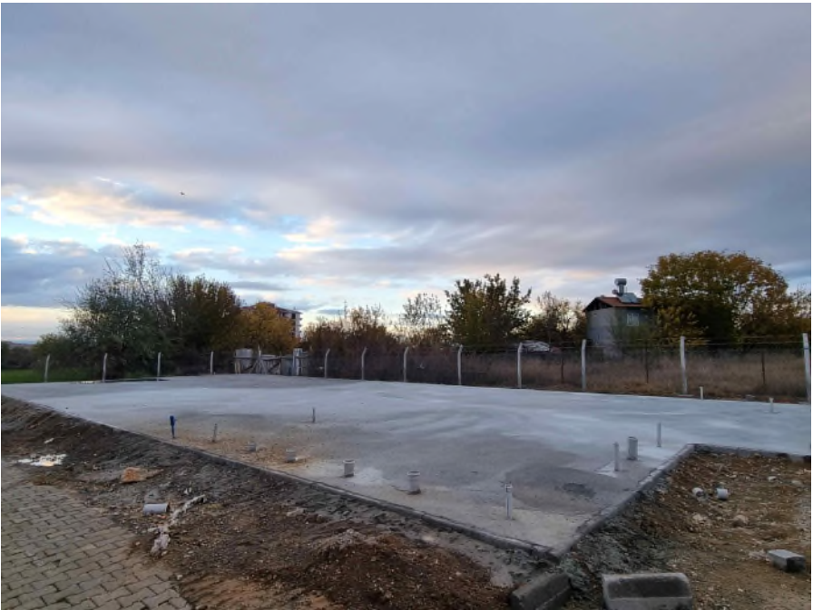
사진3. 부지 시멘트 공사
